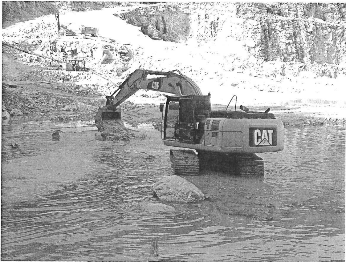
ภาพที่ 1.2 การขุดลอกปอดักตะกอน
